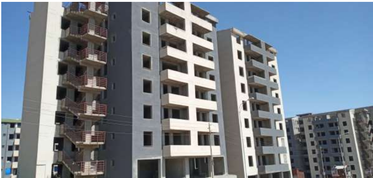
Figure II: Ajamba Condominium Project Site (Kara-Kore)
